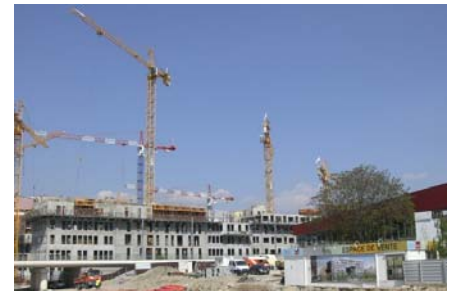
建設工事が進むリヨンのコンフレアンス地域 .....
