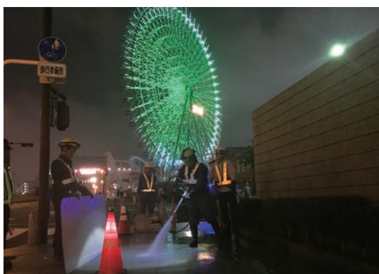
高圧洗浄清掃の様子
