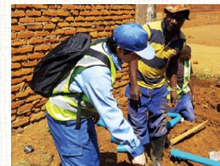
Réparation des zones de fuite en République du Malawi (juillet 2024)
