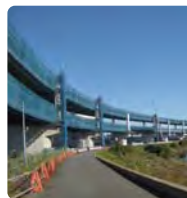
A construção do anel de auto-estrada do norte de Yokohama
