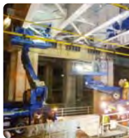
Trabajo de preservación de un puente
