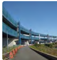
La construcción de la Autopista norte de circunvalación de Yokohama
