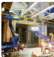
橋樑保全工程
