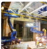
桥梁保全工程
