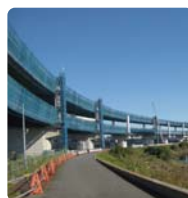
横滨环状北线的整備
