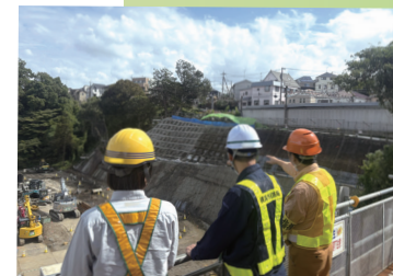
鶴ヶ峰駅付近の工事の現場確認
