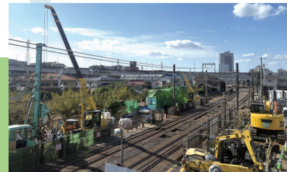
二俣川駅付近の工事状況
