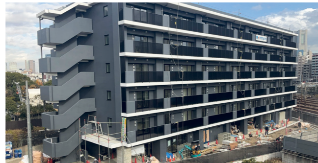
尾張屋橋住宅(仮称)建替工事
