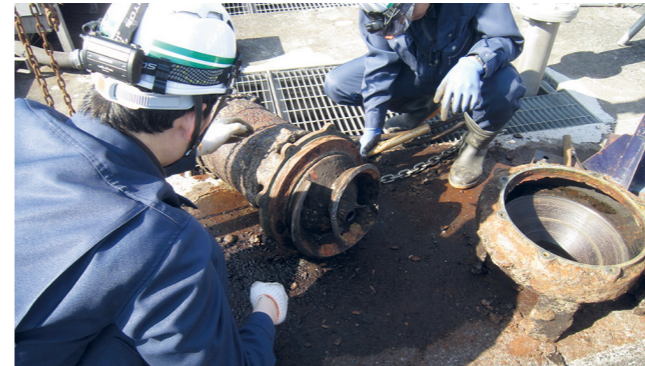
下水道施設の機械整備
