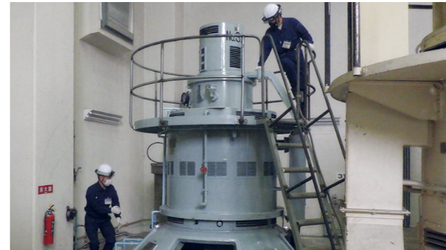
ポンプの現場確認
