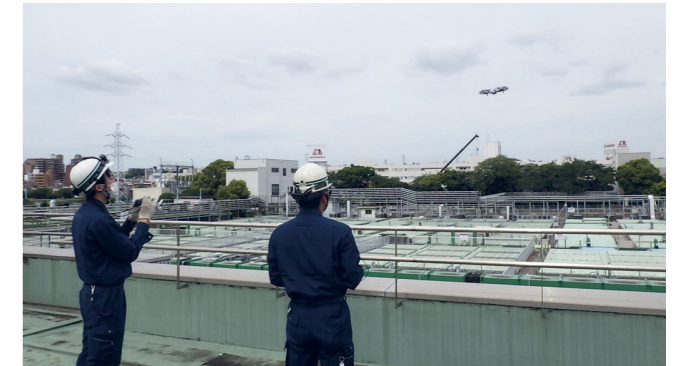
ドローンによる点検作業
