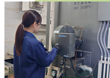
現場調査の様子
