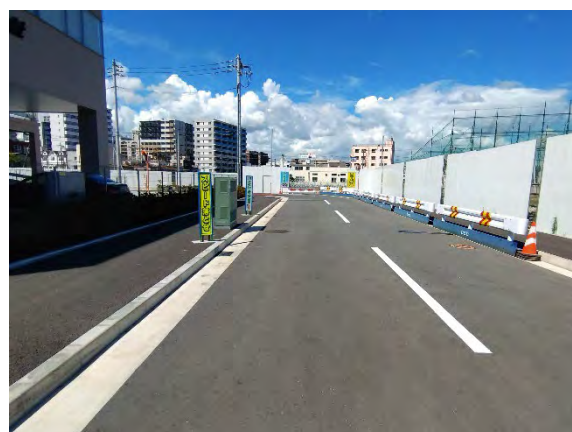
地区内道路の一部完成
