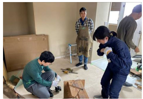
カフェのコーヒーテーブルも整備前の階段板を活用して DIY で作成
