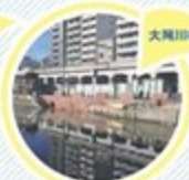
横浜日ノ出橋
