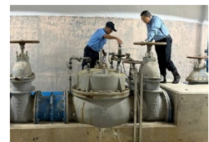
ポンプ場、配水池の点検・調査
