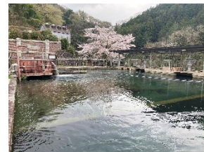
青山沈でん池
