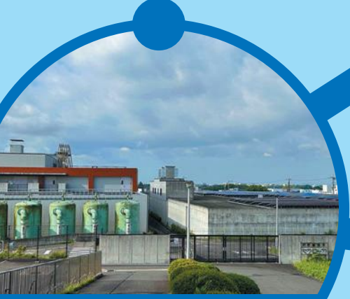
セラミック製の膜モジュールを使用した日本最大級の膜ろ過施設!
