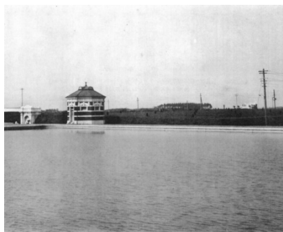
写真2 創設時の写真 (配水池浄水井上屋)
