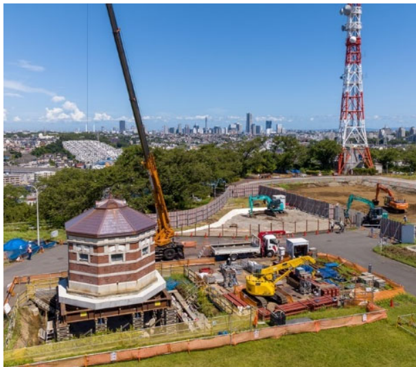
写真1 配水池配水井上屋の曳家工事の様子 （令和5年8月2日撮影）
