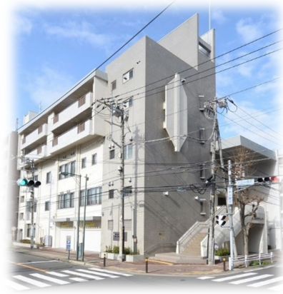
給水工事受付センター外観
