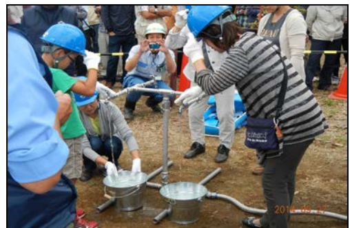
緊急給水栓(※)を活用した応急給水訓練 （横浜市管工事協同組合が用具を組立て、 地域住民が給水を体験）
