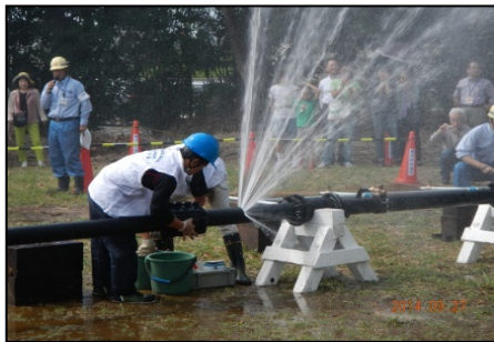
〈配水管の破裂状況〉
