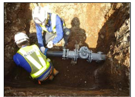
復旧工事をを行う工事事業者様
