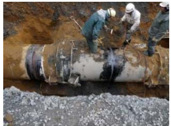
東日本大震災での応急復旧活動の様子 (茨城県)
