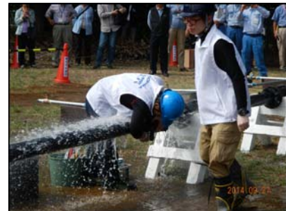
〈配水管の修繕状況〉
