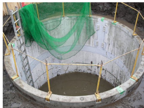
<防火水槽新設工事>
