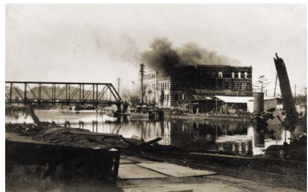
当時の横浜市庁舎の火災の様子 (2代目市庁舎 明治44年~大正12年)
