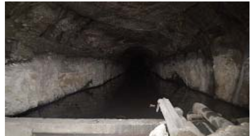
防空壕跡の入口と内部
