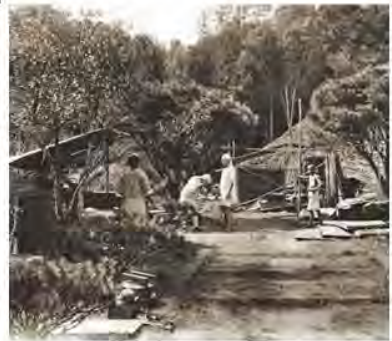
倒壊した東慶寺
