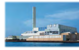
工場の新設・長寿命化工事
