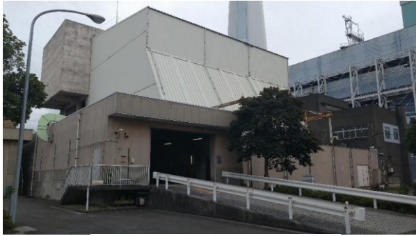
現況写真①
