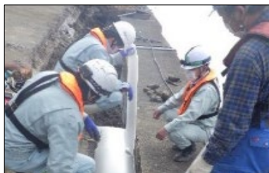
【護岸復旧工事(空洞補修)】
