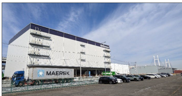
【本牧ふ頭A突堤のロジスティクス拠点】
