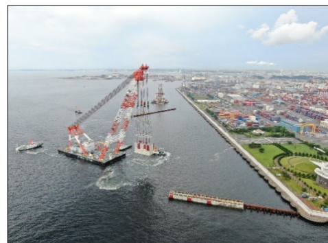
【ケーソン据付状況】
