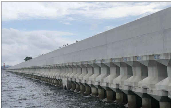
【金沢区福浦地区護岸復旧状況】
