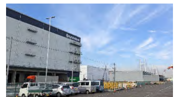
【本牧ふ頭A突堤ロジスティクス拠点】
