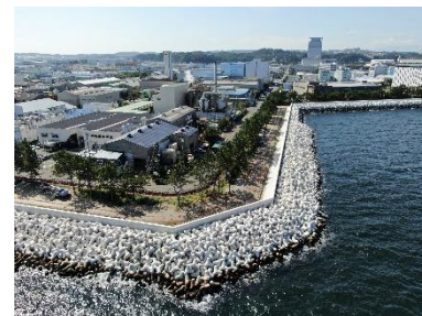
台風被害の復旧(護岸の嵩上げ)
