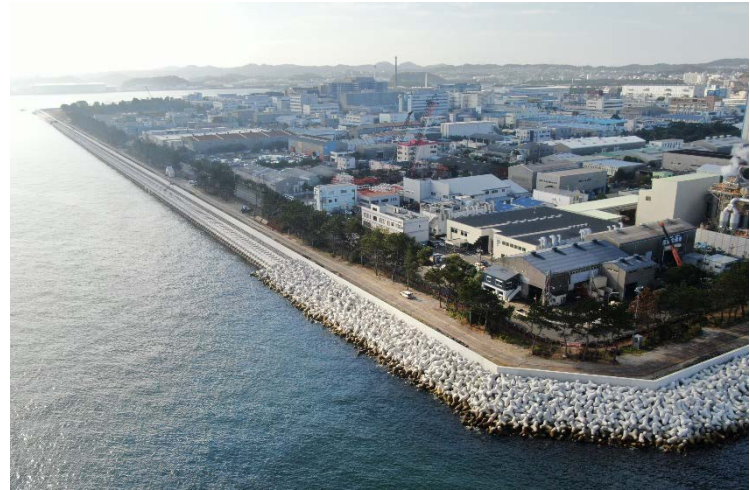
写真 護岸の嵩上及び消波ブロック設置状況(金沢区福浦地区)
