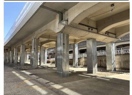
高架部の耐震補強工事
