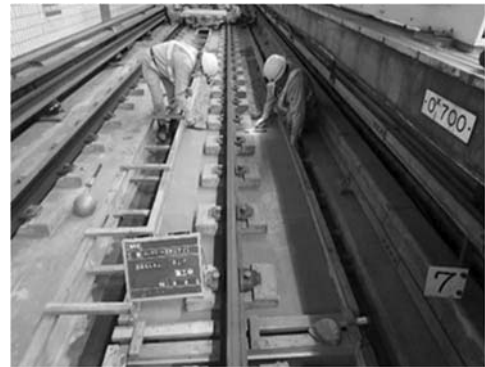
<軌道改良工事>
