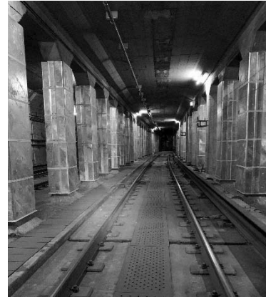
<開削トンネル部>
