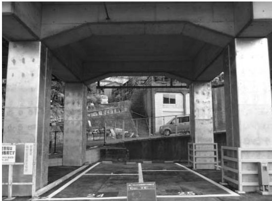
<ラーメン高架橋の橋脚の補強>
