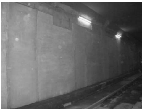
<関内駅構築補修>
