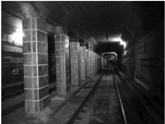
<開削トンネル中柱の補強>
