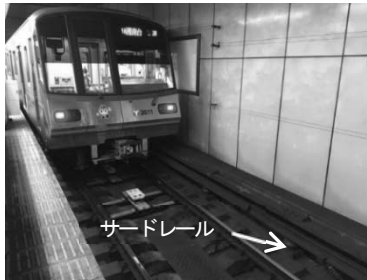
<サードレールの敷設写真>
