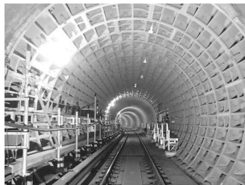
<シールドトンネルの補修>
