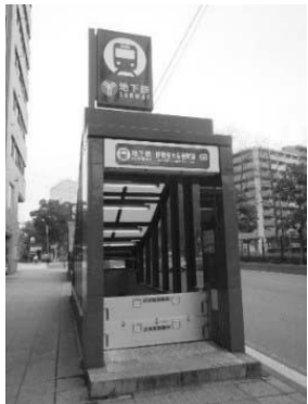
<止水板設置状況> (伊勢佐木長者町駅)
