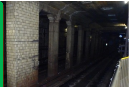
開削トンネル中柱
