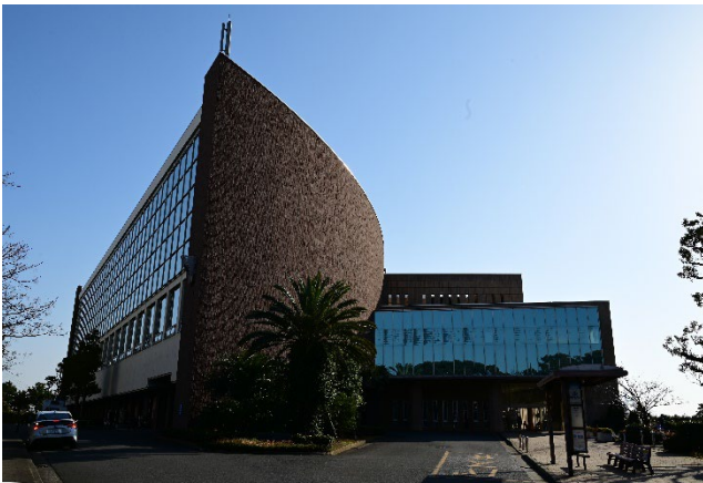
現況写真①
