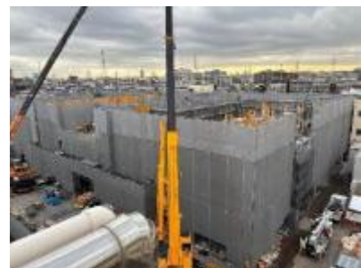
工事中の写真（令和8年3月撮影）
