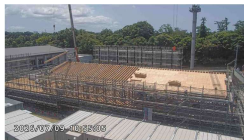
工事中的写真（令和8年7月撮影）
