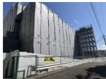
工事中の写真 （令和8年7月撮影）
