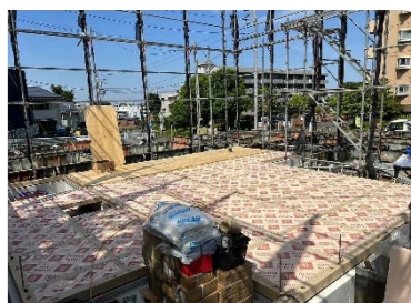
【断熱工事の状況（床）】
