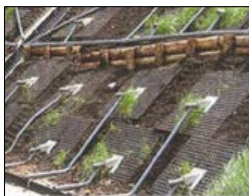
排水補強パイプ工
