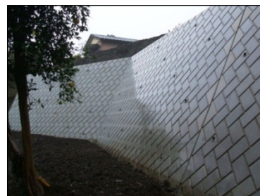
擁壁の築造（新設）
