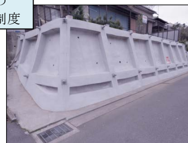
既存擁壁の補強例
