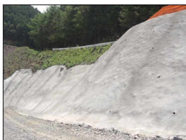
モルタル・コンクリート吹付工
