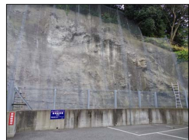
覆式落石防護網工
