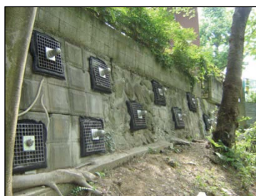
アースアンカー工
