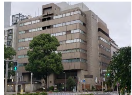
横浜市技能文化会館 外観
