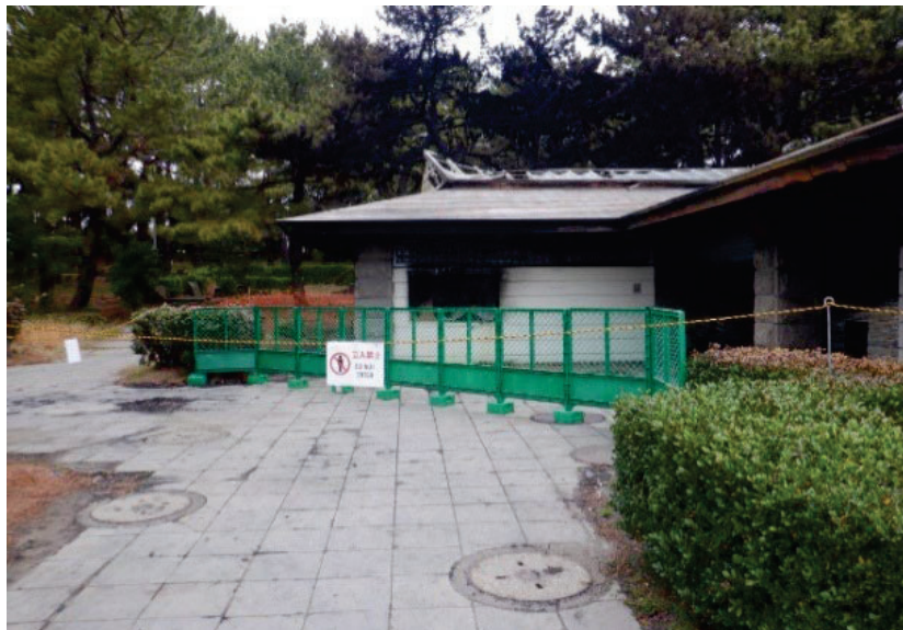
立入禁止措置状況
