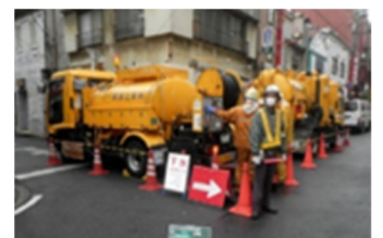
下水道管清掃状況
