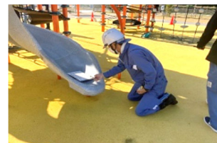
遊具等の施設点検
