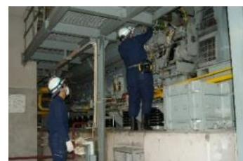
自家発電設備の維持管理
