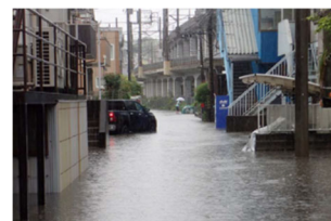
令和3年道路冠水状況
