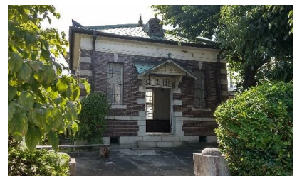
川島町旧配水計量器室上屋
