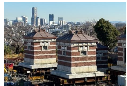
浄水場内の歴史的建造物
