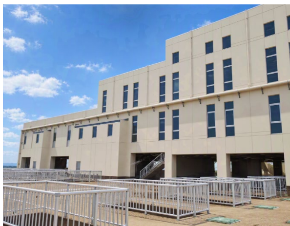
写真：30・40系電気機械棟
