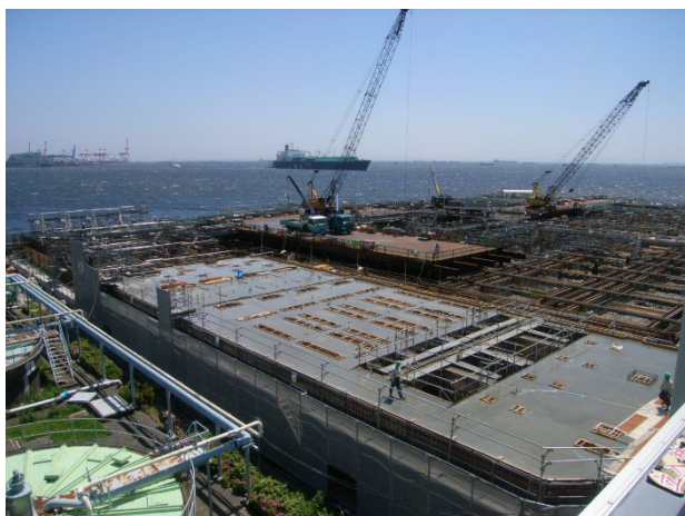
写真：30・40系水処理施設(建設当時)
