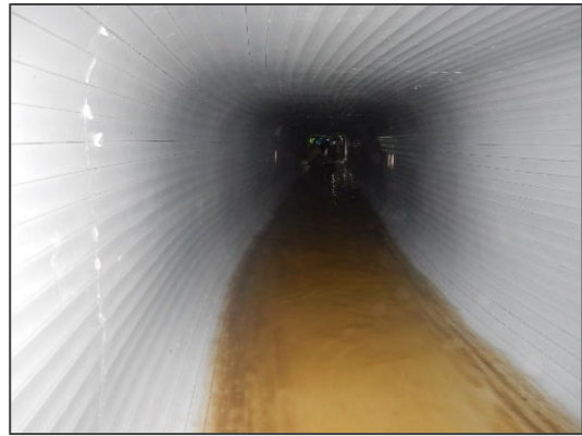
管更生工法による対策例
