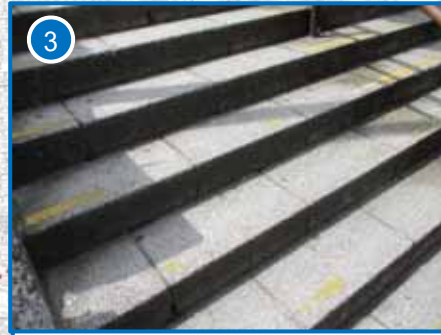
【経路】 階段の段鼻のテープ貼替え
