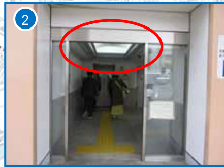
【鴨居駅ふれあい橋】 エレベーター出入口付近の照明の明るさについて改修を検討
