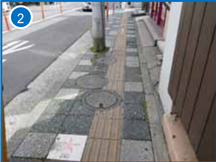
【経路】マンホール蓋上に視覚障害者誘導用ブロックを設置
