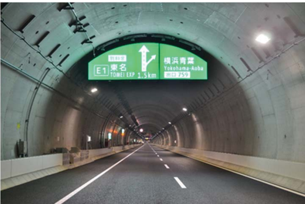
③横浜北西トンネル
